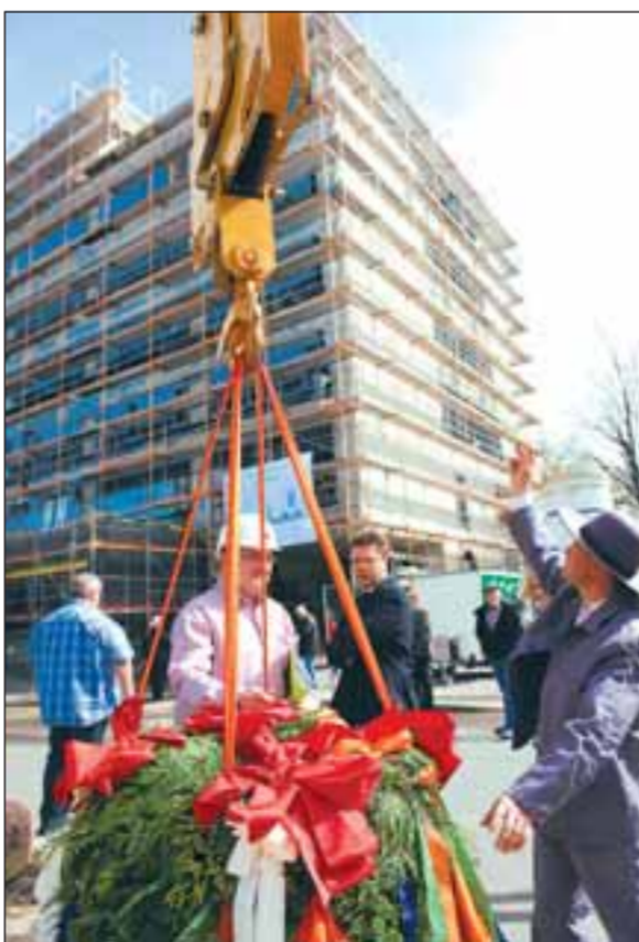
Der Richtkranz prangt jetzt über dem Neubau des Pathologischen Institutes in der Kirschnerstraße. Foto: Kresin
